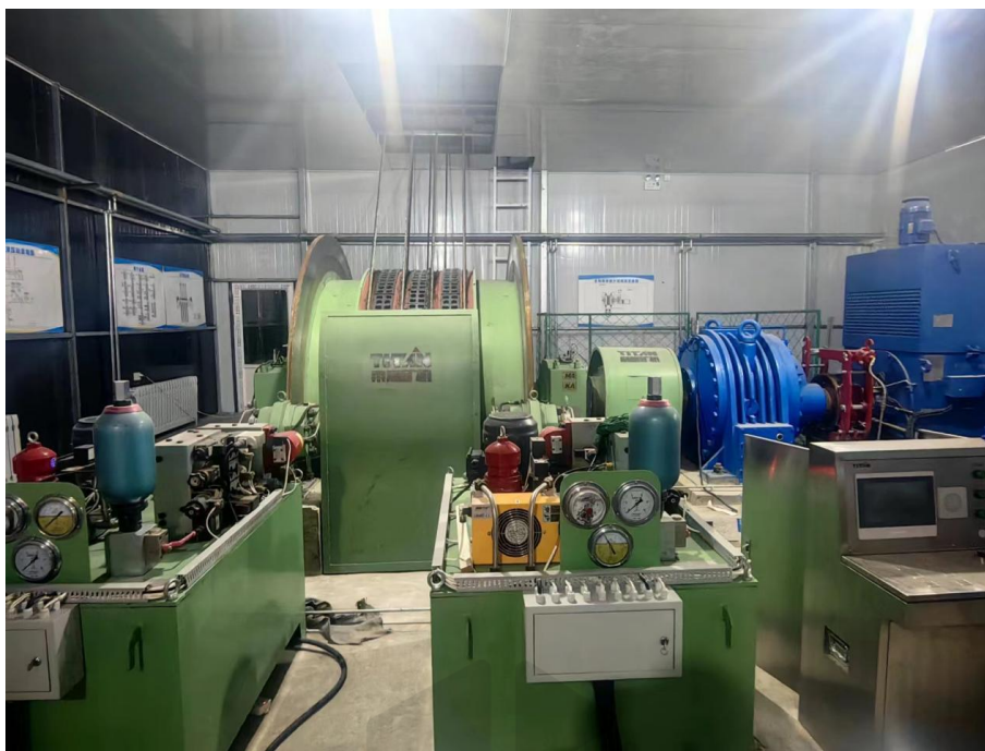
图 2.5-5 竖井 SJ3 提升机房
