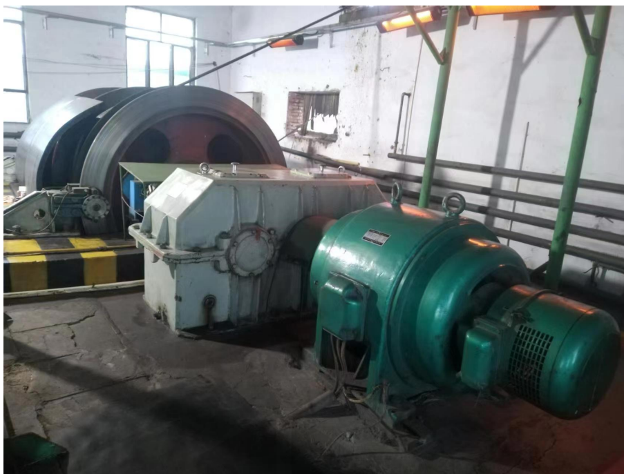
图 2.5-4 竖井SJ2 提升机房
