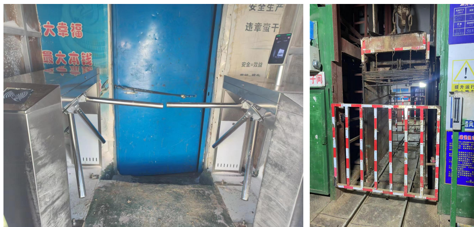
图 2.5-2 竖井SJ2 出入口及罐笼
