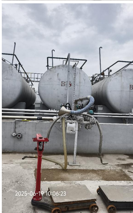
现场勘查照片
